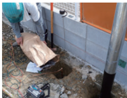
②カーボンアースを敷設
