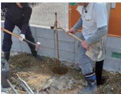
①規定通りアース棒を打設
