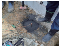
③敷設完了
