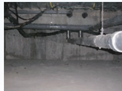
地下ピット工事に
