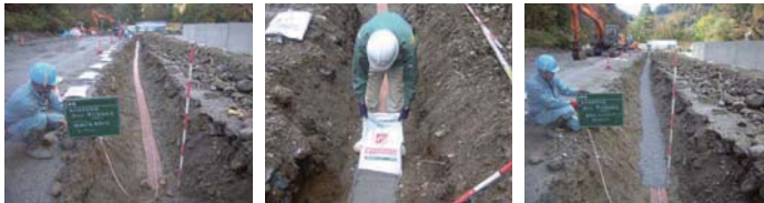
①パワーメッシュ裸銅線敷設 ②ホクデンEP-1敷設 ③敷設完了
